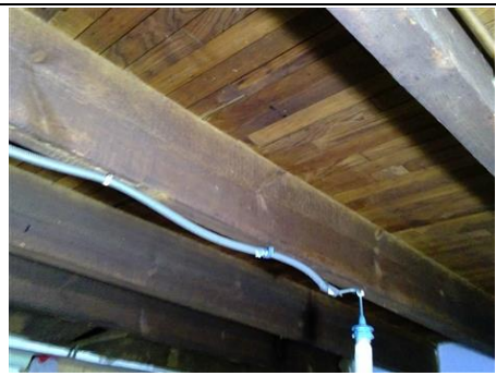
Photo n° PhTer001 Localisation : Rez de Chaussée - Chaufferie Ouvrage : Plafond - Poutres bois lames de parquet Parasite : Insectes à larves xylophages Indices : orifices obturés ou non (présence sur tout l'élément concerné) Localisation sur croquis : 001
