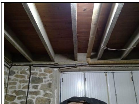
Photo n° PhTer007 Localisation : Rez de Chaussée - Garage Ouvrage : Plafond - Poutres béton lames de parquet Parasite : Insectes à larves xylophages Indices : orifices obturés ou non (présence sur tout l'élément concerné) Localisation sur croquis : 007
